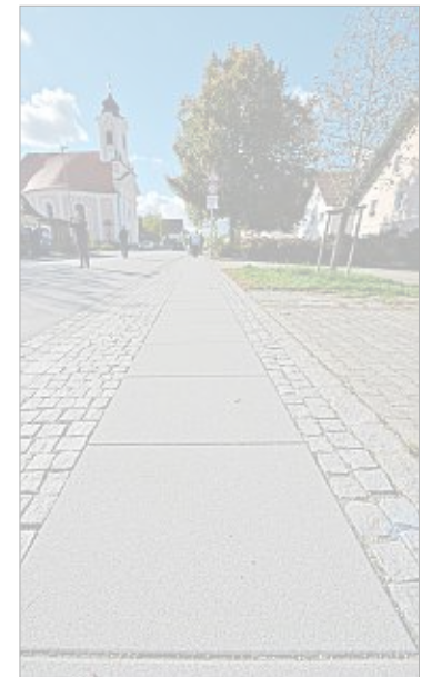
Für die Gestaltung der Gehsteige hat man an der Staatsstraße in Dommelstadt eine Mischung aus Kleinsten und Platten gewählt. Eine Lösung, die auch für die Hartkirchner Straße in Pocking denkbar wäre.
